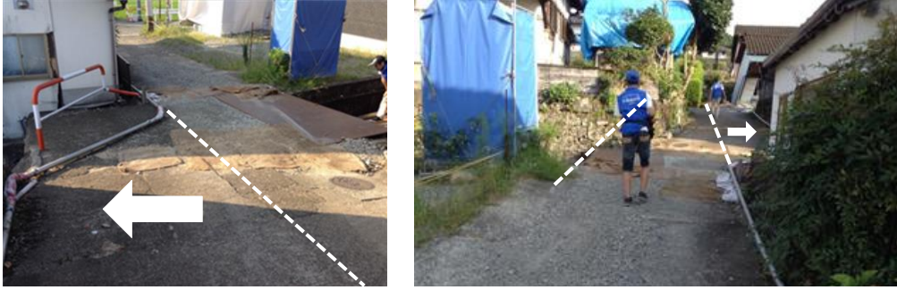
もともとは点線のような道でしたが、矢印の方向に大きくずれてしまいました。
